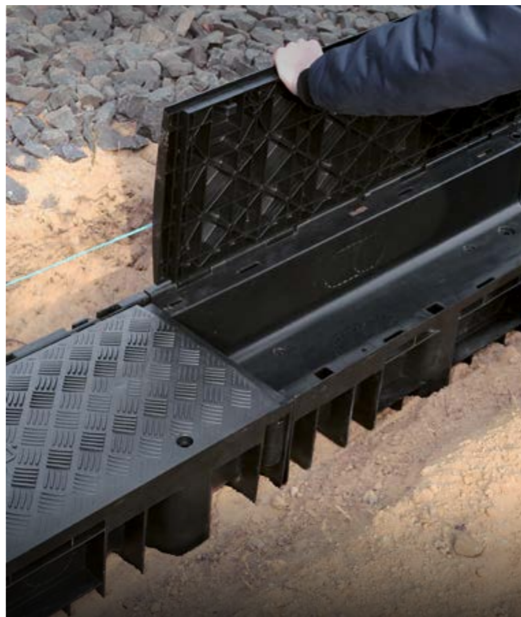
Rys. 2: Montaż pokrywy
